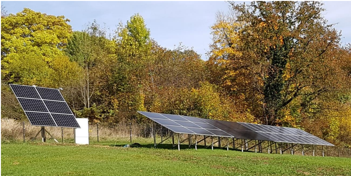
Abb. 3: Nachgeführte und stationäre Photovoltaik Anlage mit unterschiedlichen Modultypen des EAS-Labs (Quelle: eigene Darstellung)
